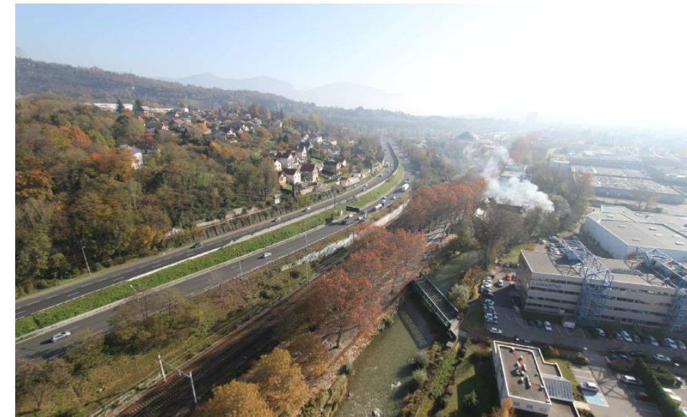
Photo 22 : Vue aérienne de la VRU et de la voie ferrée entre les échangeurs 15 et 16 (photo DIR Centre-Est)
