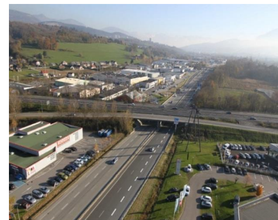
Photo 23 : Entrée d'agglomération (franchissement autoroutier)
